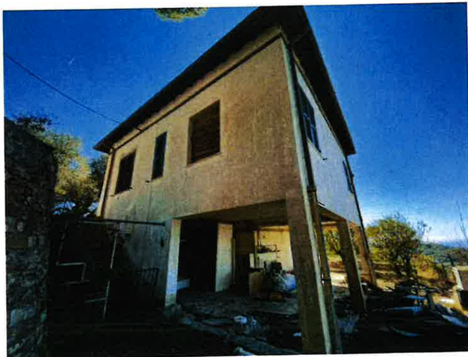
ALLEGATO 3.2 – Vista Esterno
